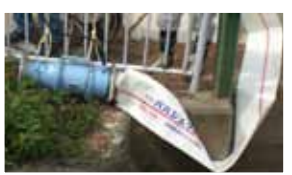
大型排水ポンプ
