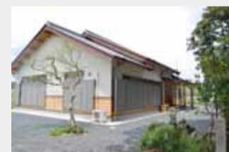
南側からの全景
